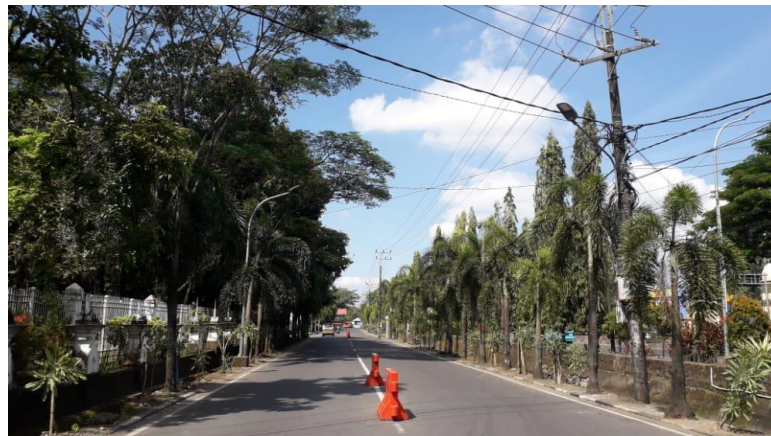
Gambar 5. Tampak Jalan Raya di Sekitar Hutan Kota
